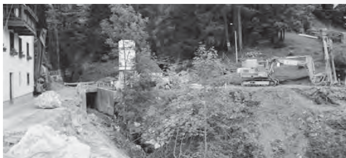
Il cantiere per il nuovo ponte sul Rio Chiesa a Retiz
