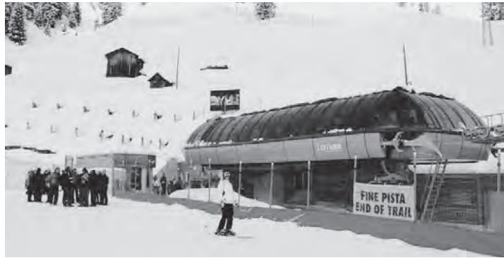
Una veduta della nuova seggiovia.
