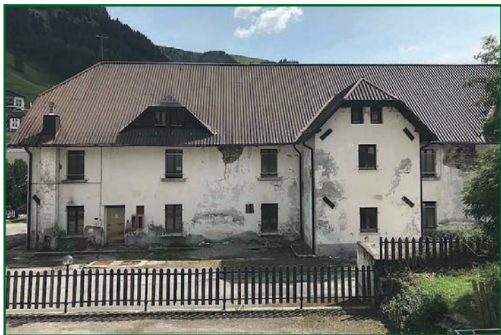
La vecchia caserma "Gioppi" ad Arabba, di cui è iniziata la demolizione.
