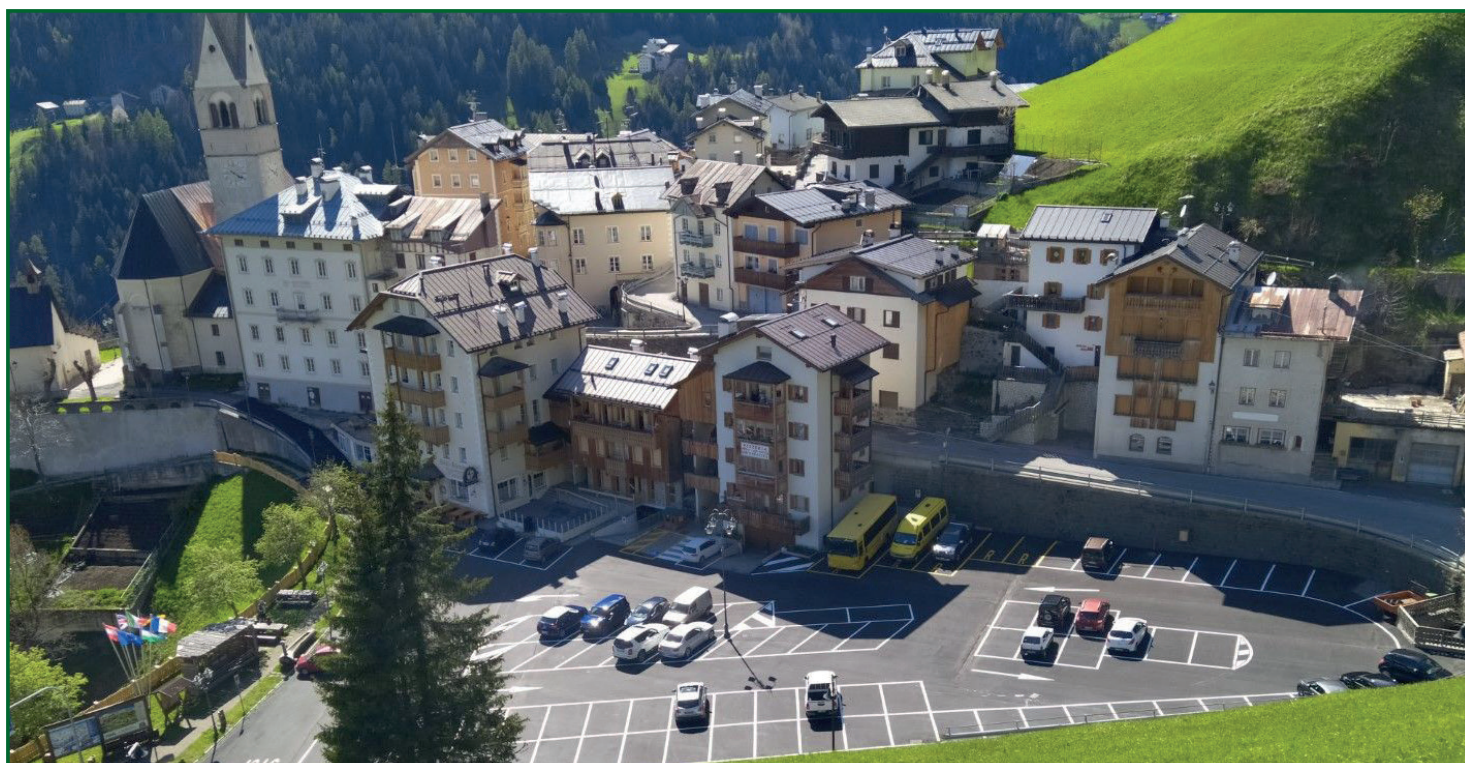
"Piazza Nuova" di Pieve con il nuovo asfalto.
