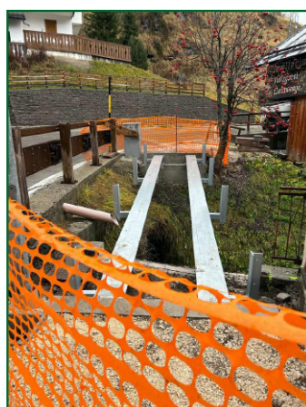
Un tratto dei nuovi marciapiedi in costruzione ad Arabba.
