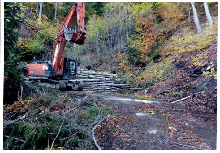
Lavori sulla strada di Codalonga.
